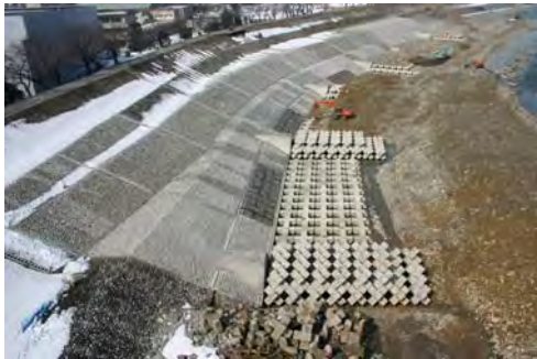
図 5-12 急流河川対策（根継ぎ護岸工）
