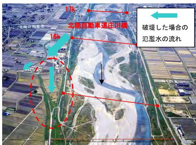
図 3-24 右岸 15.0 km 付近の霞堤
