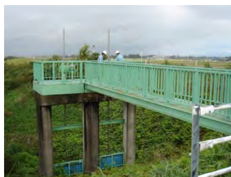
図 5-35 河川管理施設の点検
