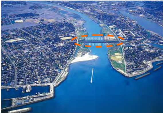
図 5-7 橋梁架替箇所の状況
