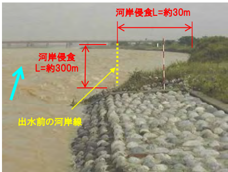
図 5-11 河岸の侵食状況（H11 洪水）
