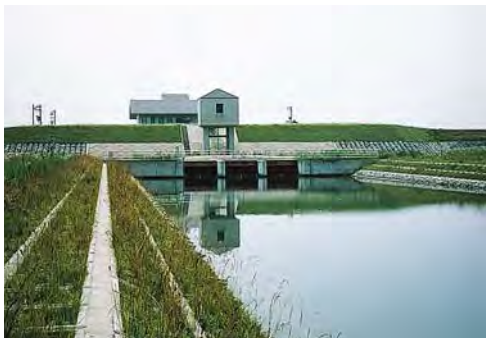
図 5-40 内川流域浄化揚水機場・取水樋管
